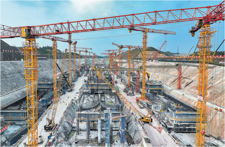
平陆运河建设现场
