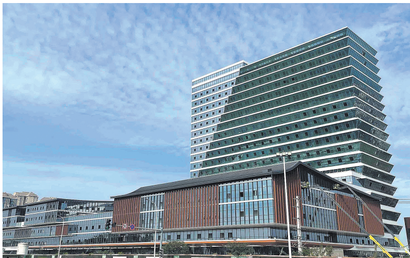
新津区人民医院新院区已完成主体结构建设
