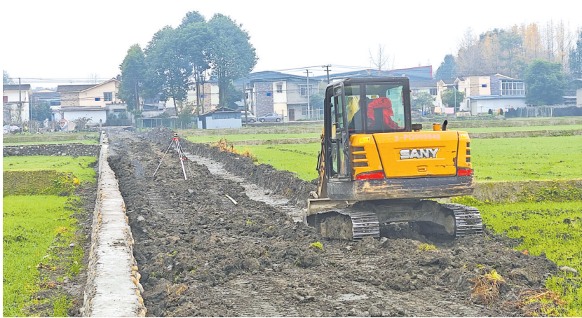
挖掘机开挖沟渠
