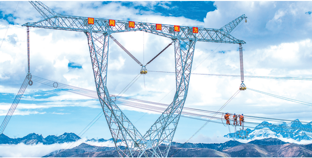
2024年6月2日,川渝特高压工程1000千伏输电线路飞越折多山,在21米高空,国网四川电力施工人员配合安装间隔棒及其附件。
