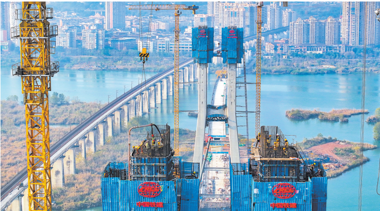
遂宁涪江特大桥建设现场。受访者供图。
