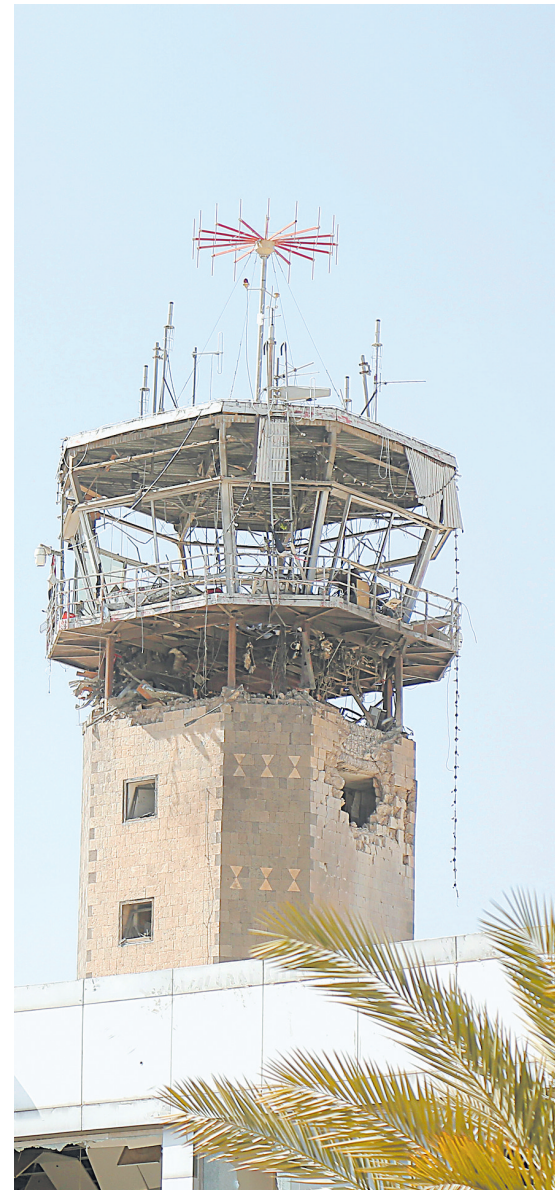
这是12月27日在也门萨那国际机场拍摄的在以色列空袭中受损的塔台。
