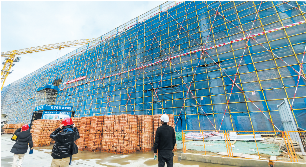
项目建设现场。
