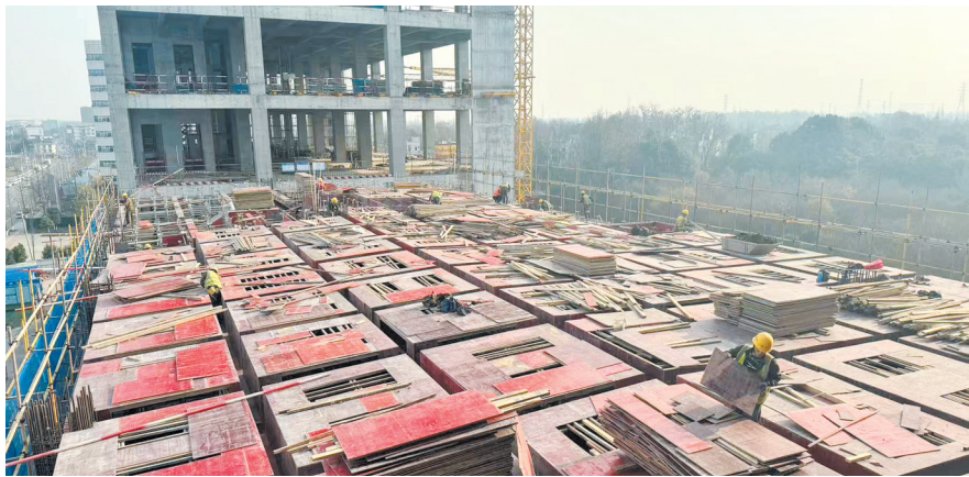
成渝数字科创产业园工业标准厂房项目建设现场，工人正加紧施工。
