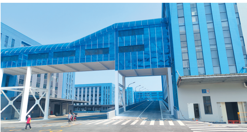
中通快递西南总部项目。
