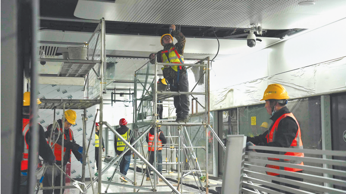
轨道交通建设者加紧施工。
