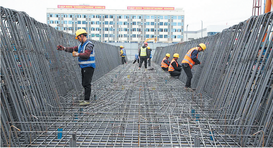
成眉S5线施工现场。受访者供图
