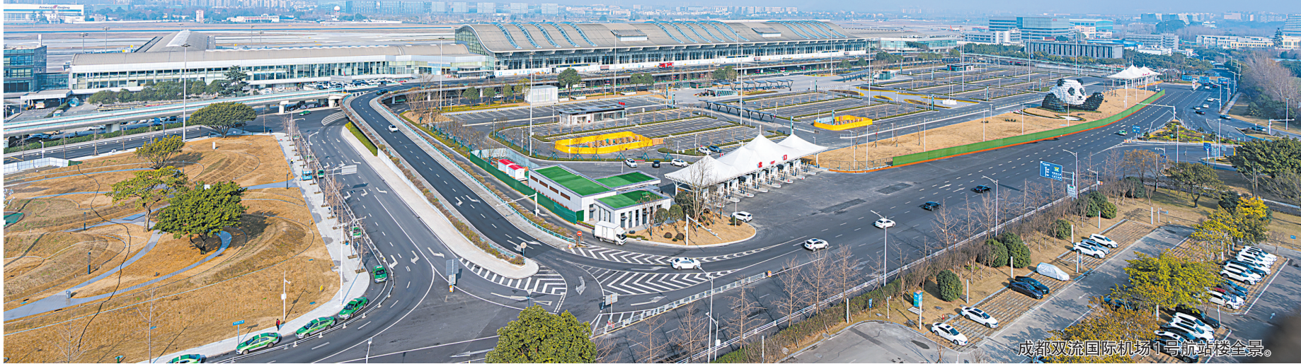
成都双流国际机场1号航站楼全景。
