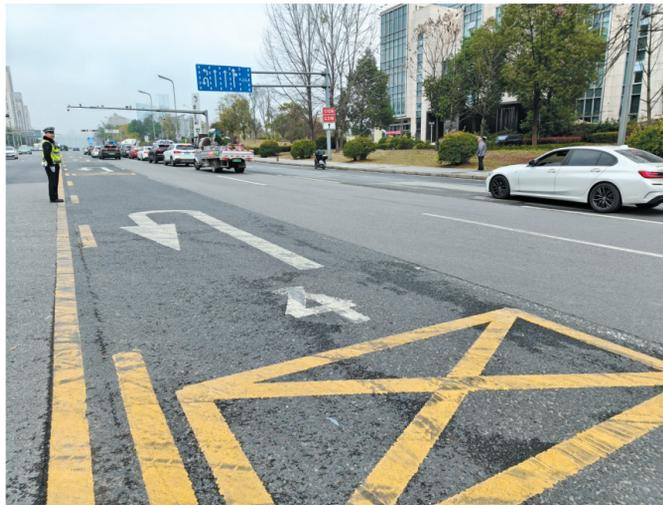
麓山大道二段和韵南路口设置的“多车位串联掉头”车位。
