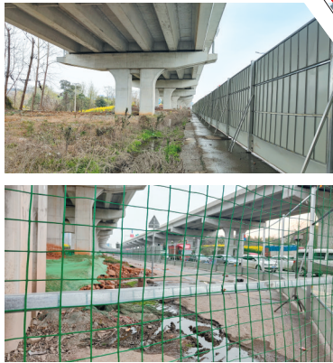
很多打围的地方占据了道路资源,但并没有进行施工。
