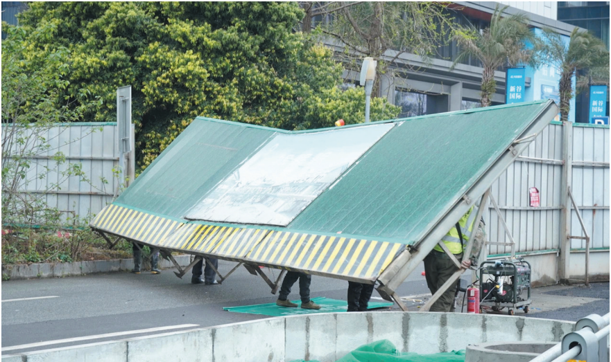
施工人员正在拆除围挡。
