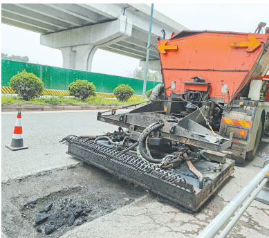
施工车辆正在对路面进行修补。
