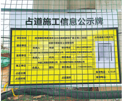
打围施工路段已增设施工告示。
