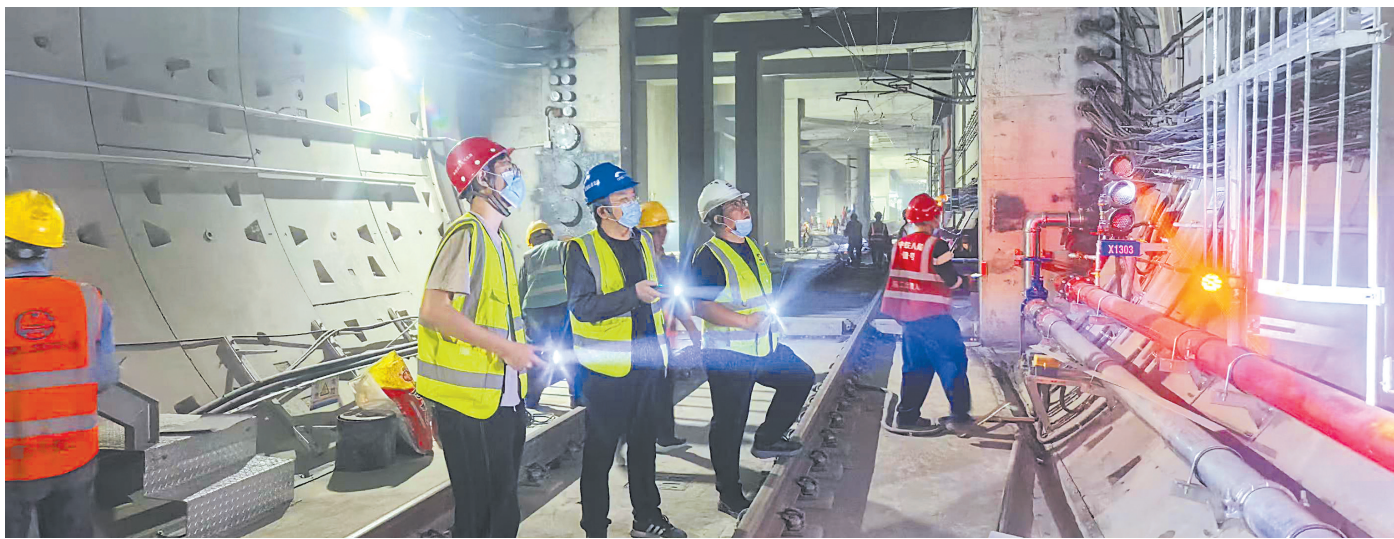
工作人员对13号线一期开展接触网施工检查。
