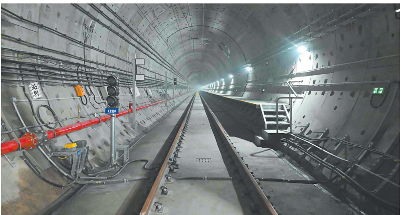
轨道交通13号线一期工程区间隧道完成移交。
