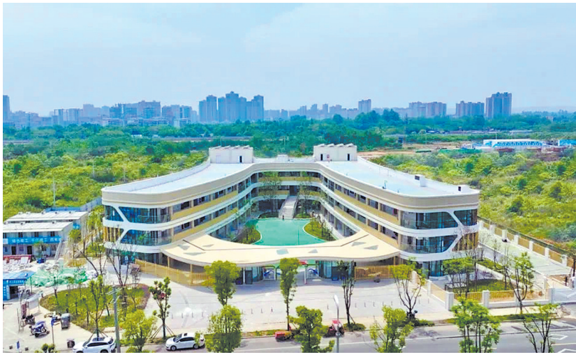
邛崃高铁片区幼儿园已完成建设。
