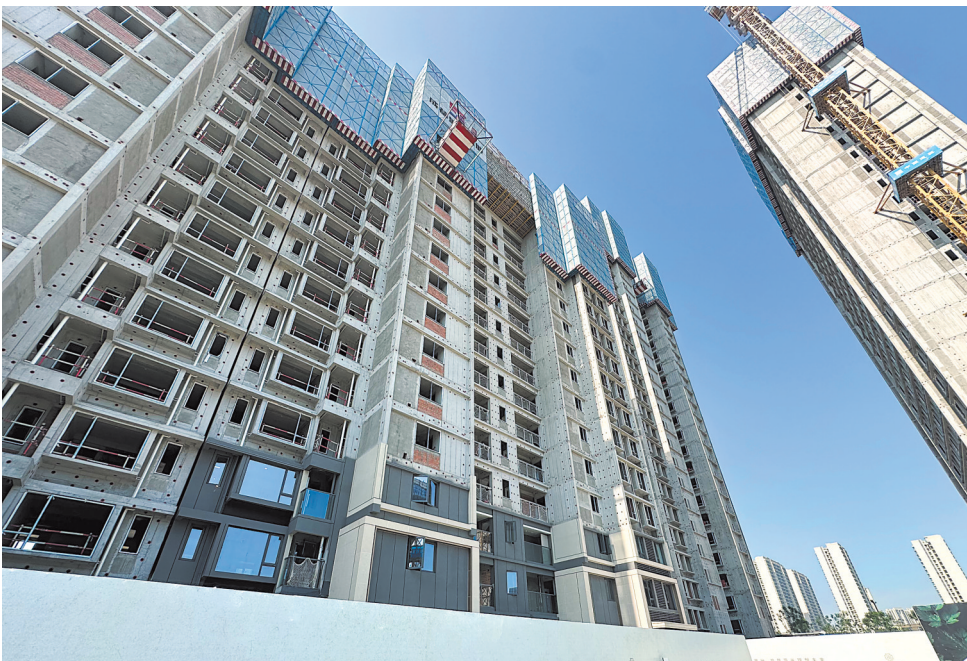
项目正在进行主体结构施工。
