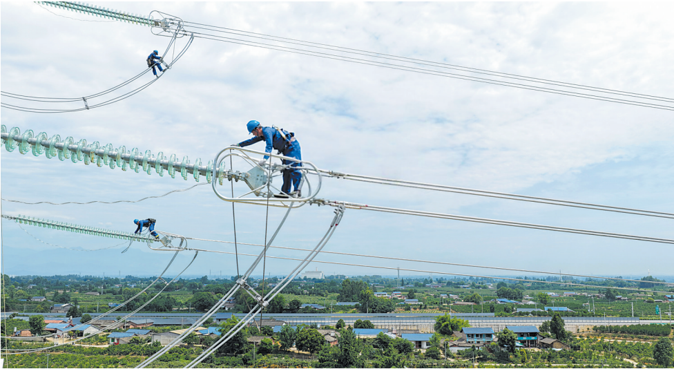
电力工人走线验收。
