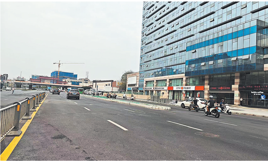
围挡拆除,道路变宽,市民出行更方便。
