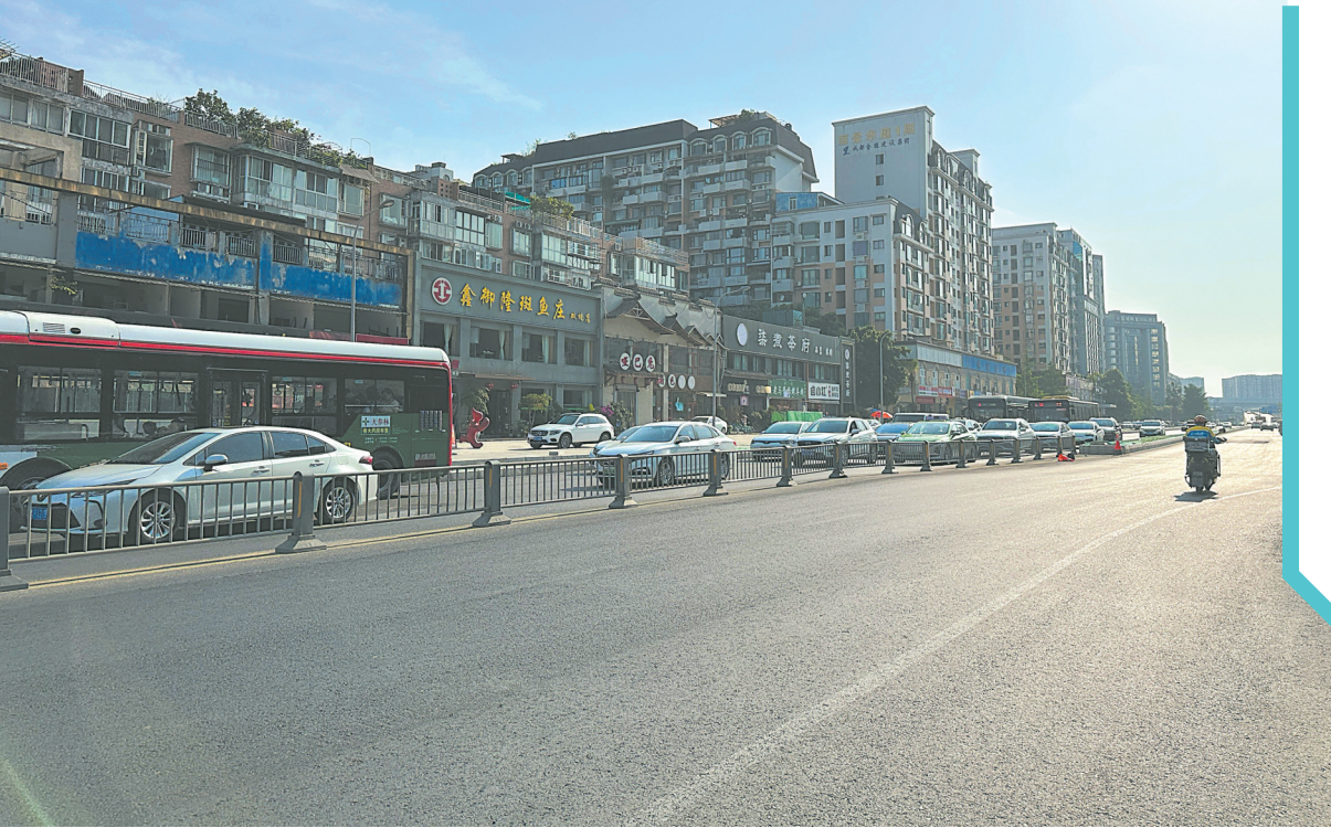
清水河大桥站退园后新铺装的沥青路。
