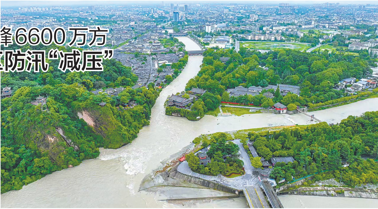
为减轻内江四大干渠的过流压力，都江堰灌区指挥中心调度开启渠首工业闸泄洪。
